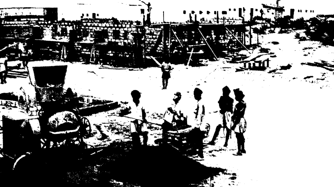
Construcción de viviendas en Nuakchott —Una nueva capital se edifica
