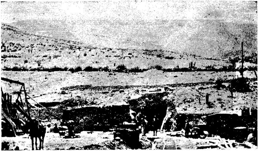
Tamaya —Boca del socavón nuevo; en el fondo el Cerro
