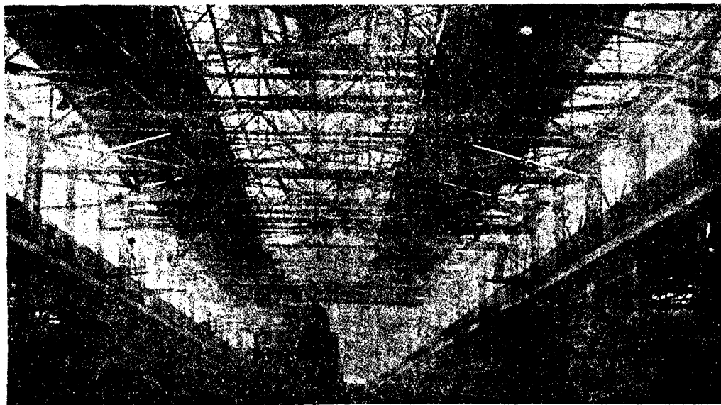
El taller mecánico de montage.
